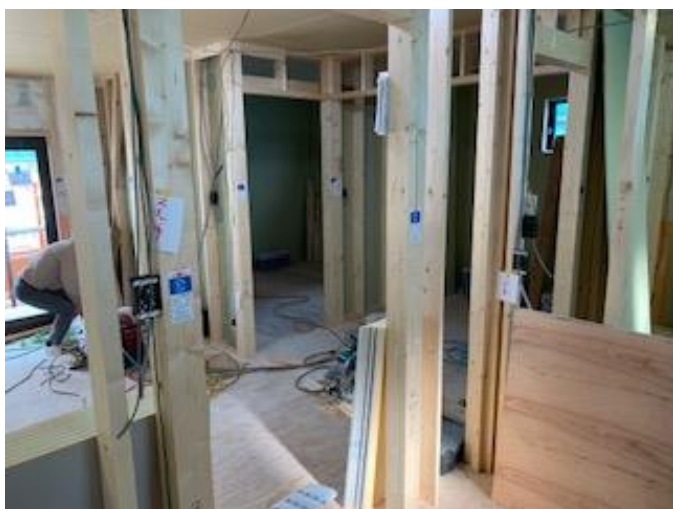
内装と電気工事
